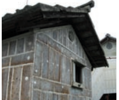
■横張り石の位置を妻面と桁方向で違い、目地以外に和釘を打ち、漆喰留めした蔵
