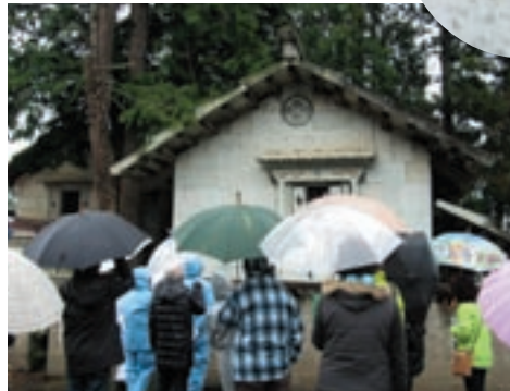
■板蔵に石を和釘で止め、目地処理をしない蔵。窓廻りは和風の意匠 「徳次郎石の瓦は百年とも云われた。また、和・洋風の建築意匠、装飾などを刻むに最適な硬さ、加工性にも優れ、それぞれの部位に用いられ重宝された。西根集落で使われている石は、もちろん徳次郎石が最も多く、ほかに大谷石や新里石なども使われている。この集落に石の建築が多い理由として、「一度重なる大の歴史」が伝えられている。それが事実としても、石の建築による町並みを造るには、木造の建築を造るより遙かに長い時間が必要だと思われる。材料の確保、加工や施工を行う人の手配、資金の調達、どれをとっても一朝一夕には不可能なものばかりである。おそらく、何らかの契機により、長い時間により住民の共通の意識・理解が生まれ醸成されたに違いない。」
