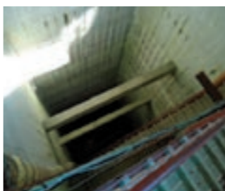
■「石の里 希望」の堅坑上から見る様子
