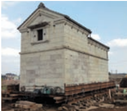
180°回転完了(曳き家施工状況)
