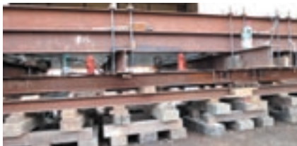
ジャッキアップの状態
