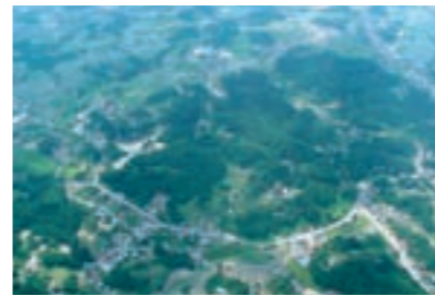
空から見た大谷地区(緑の下には、巨大な地下空間(採石跡)が眠っている)
