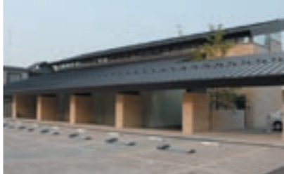
栃木信用金庫桜通り支店 ■平成19年第19回栃木県マロニエ建築景観奨励賞、同年第11回宇都宮市まちなみ景観賞
