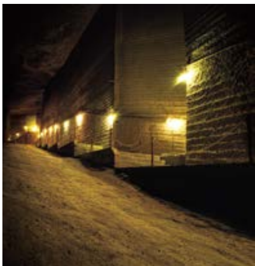
資料館内部の斜路及び見学用通路階段。壁面は採掘跡の縞模様。
