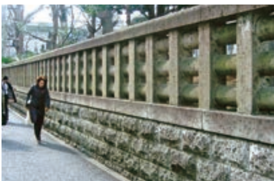
築地本願寺境内北側大谷石積塀
