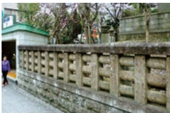
地下鉄日比谷線築地本願寺前駅舎大谷石積塀
