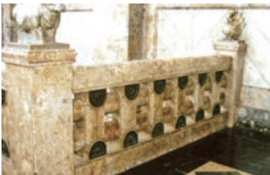
築地本願寺本堂入口階段手摺(大理石)
