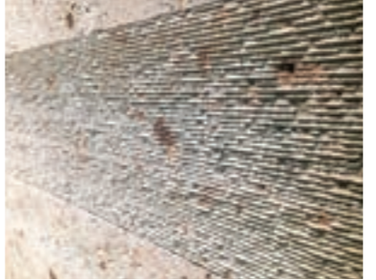
通路壁面に使用されている見たことのない仕上げ
