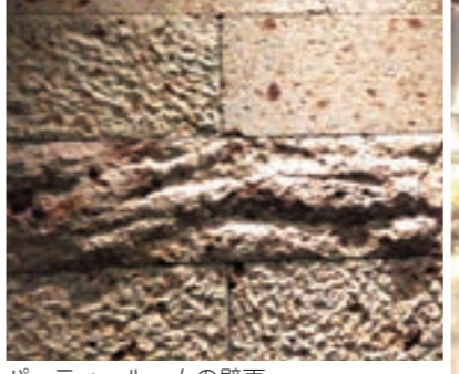
パーティールームの壁面見たことのない仕上げ
