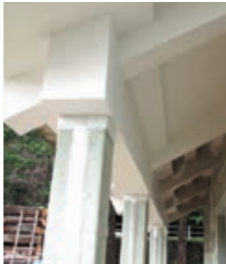
改装後下屋部分
