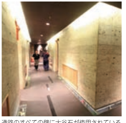
通路のすべての壁に大谷石が使用されている
