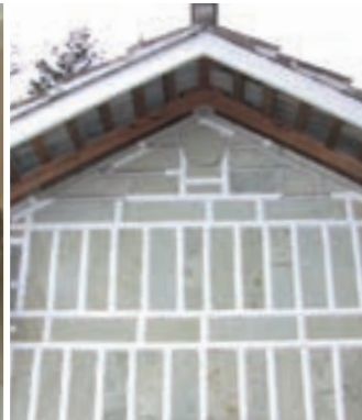
改装後外壁部分
