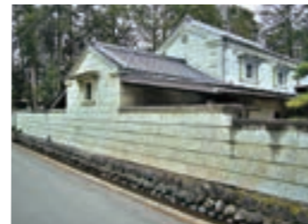
石垣と一体化した複合型大谷石建物
