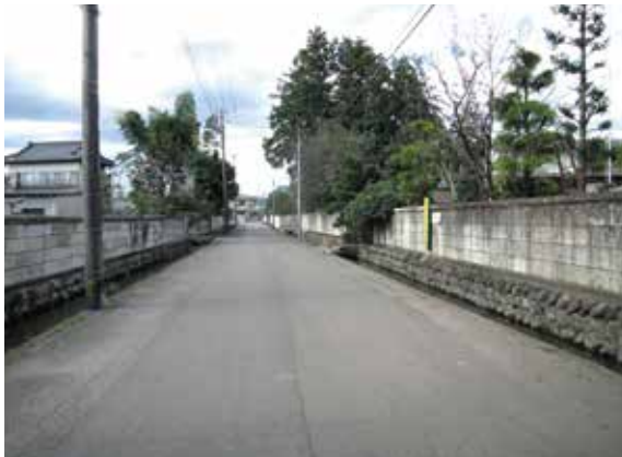
道路の両側に水路・玉石垣・石塀が連なる(上田町)
