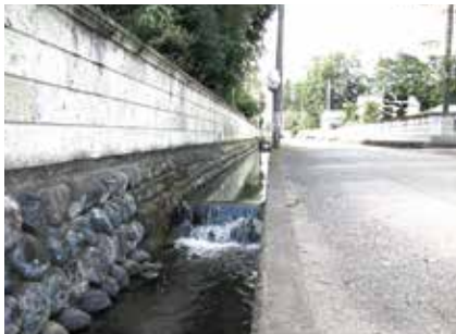
水路の所々に堰がある(上田町)
