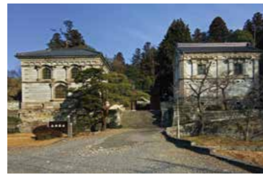
屏風岩石蔵(西蔵明治41年築・東蔵明治45年築)
