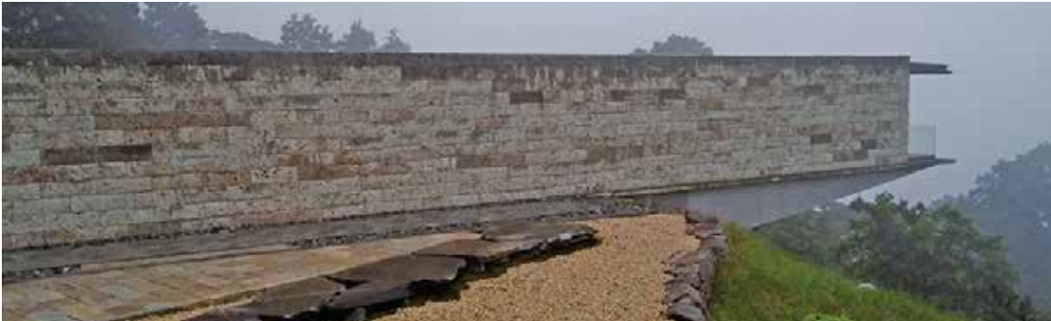
江の浦測候所「長さ100mの大谷石の外壁」
