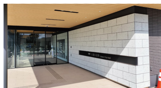
写真4 壁面に十和田石が使われた大館市役所本庁舎の入口
