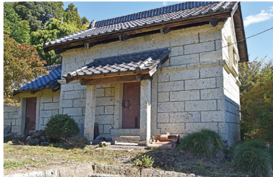
天保11年に造られたとされ、修理しながら使われている石蔵
