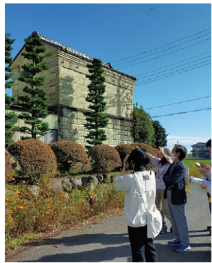
通りから石蔵を調査する様子
